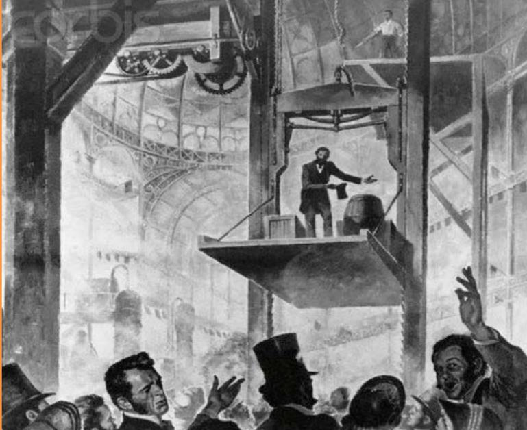
Das ist die Höhe! 1854 präsentiert Elisha Graves Otis in New York den ersten absturz sicheren Aufzug. Dafür lässt er sich auf einer Plattform nach oben ziehen – dann schneidet sein Assistent das **TRAGSEIL** durch. Und die Plattform bremst sich selbst!
